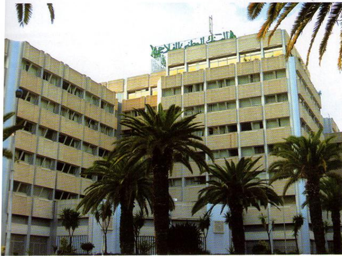
Des ébauches de ramener l'ornementation à la typologie des bâtiments tertiaires de grande hauteur ont été expérimentées dans les sièges de la STB et de la BNA avec des panneaux de façades en béton architectonique galbés avec des motifs imprimés depuis le coffrage.
