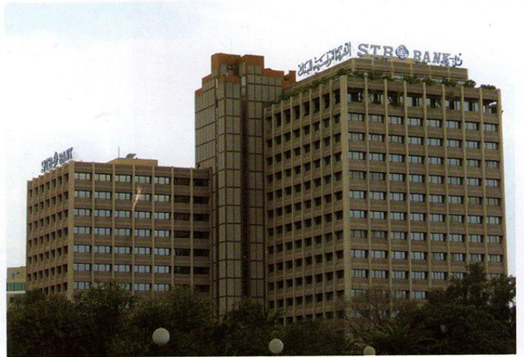
Des ébauches de ramener l'ornementation à la typologie des bâtiments tertiaires de grande hauteur ont été expérimentées dans les sièges de la STB et de la BNA avec des panneaux de façades en béton architectonique galbés avec des motifs imprimés depuis le coffrage.
